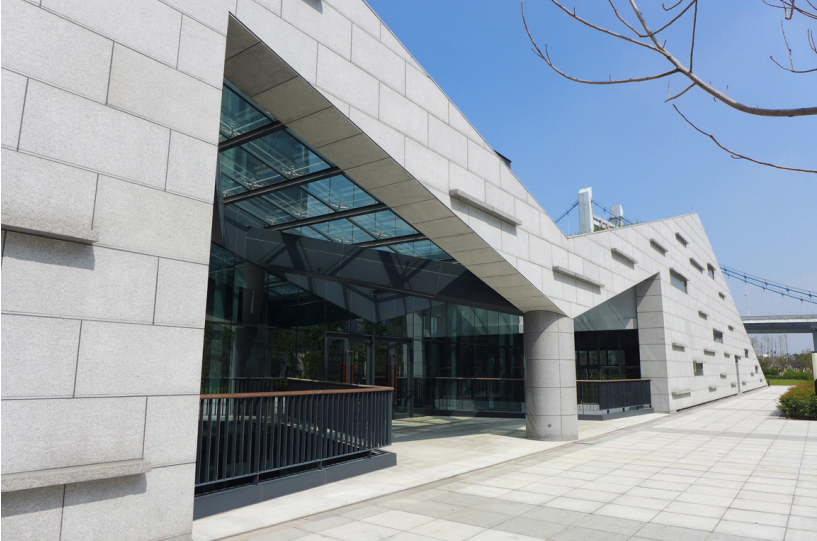
Exterior Photo: Zhang Jingang. 1
