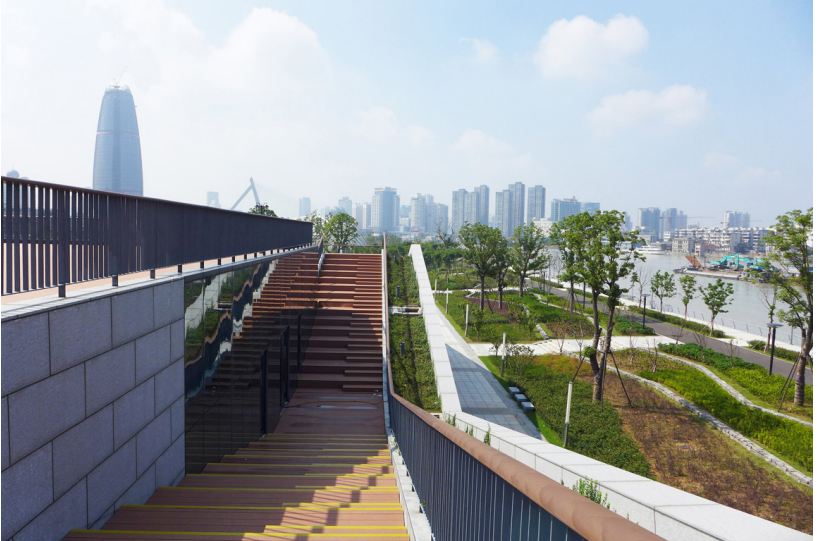
Exterior Photo: Zhang Jingang. 1
